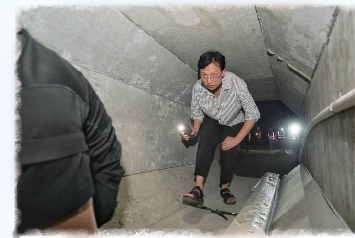
今年8月16日,记者叶楚榕探访神定河大桥桥梁检测过程。
