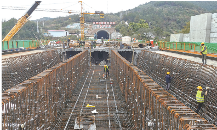
黄石梁隧道施工现场,建设者加紧施工。
