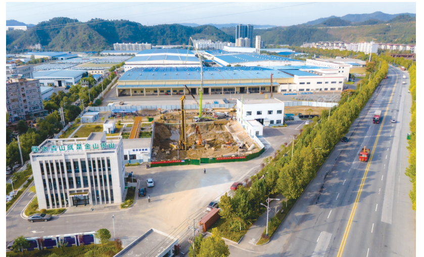
十堰东部污水处理厂工程桩基施工已进入尾声。
