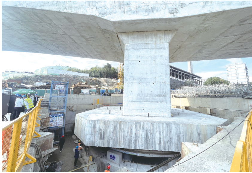
上下一体、底部转体是此次施工的一大亮点。
