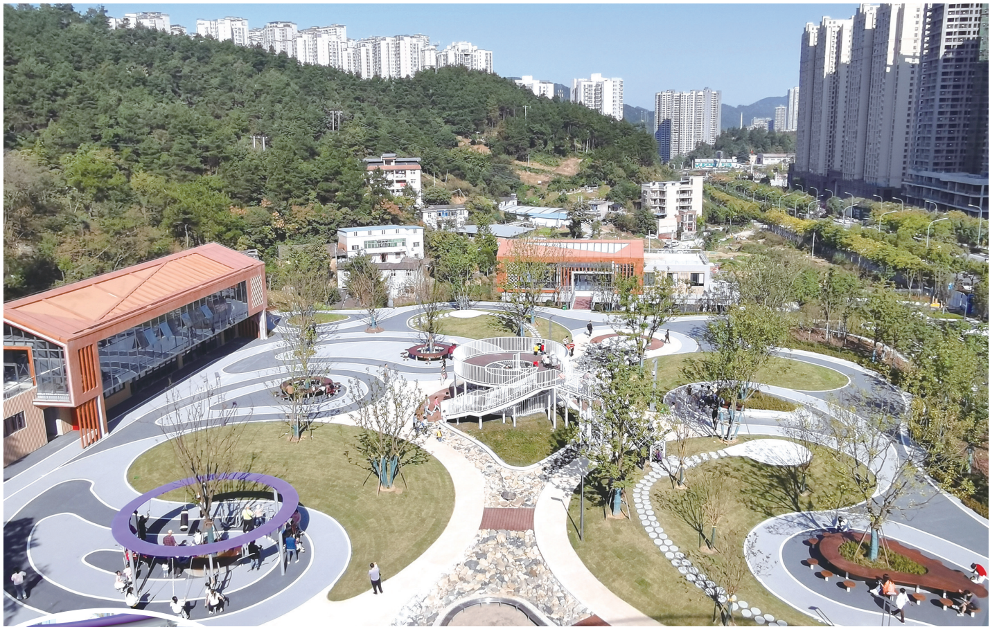
紫霄大道紫园多功能旋转滑梯、太极形沙池、健身圆盘等游乐设施已安装完毕。
