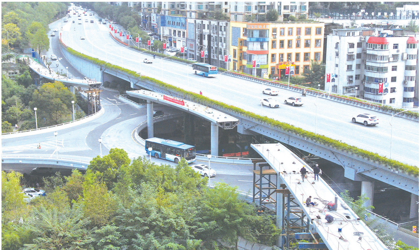
工人们在人行天桥上加紧施工。
