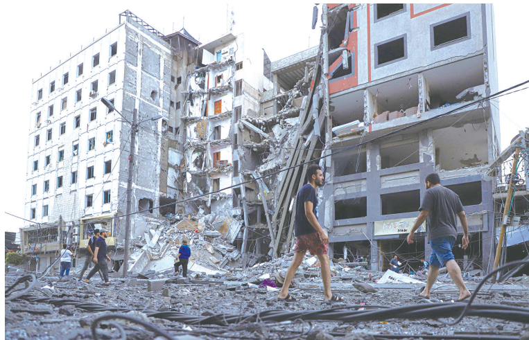
10月8日,巴勒斯坦人在加沙城查看以色列空袭后的建筑废墟。
