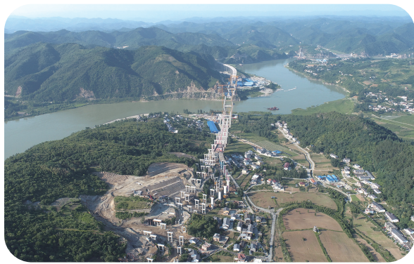
十巫北高速建设全面加快推进。
