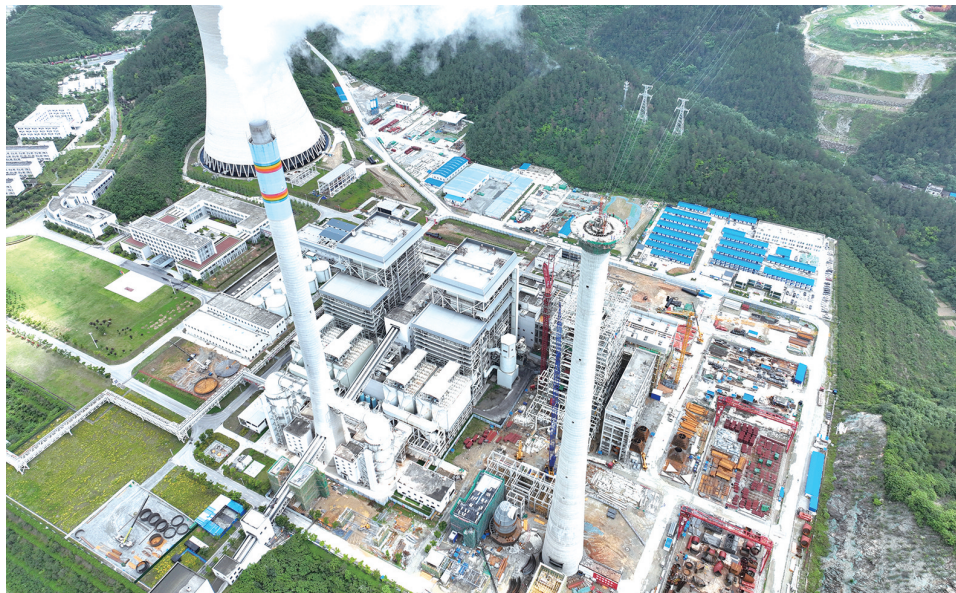
京能热电联产二期项目建设如火如荼。图/记者 张建波
