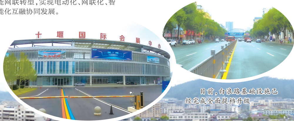
十堰国际会展中心室外展区场地平整等工作已完成。
