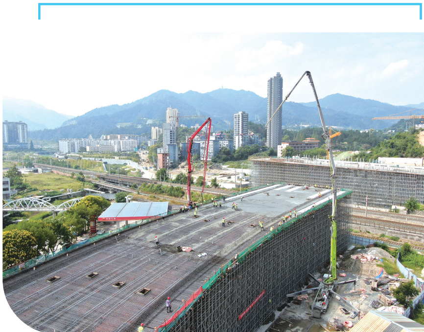
桥梁工程非涉铁段完成最后一联浇筑。
