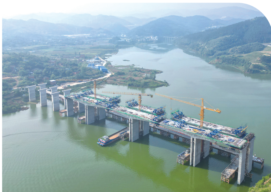
神定河大桥首个边跨合龙段浇筑完成。
