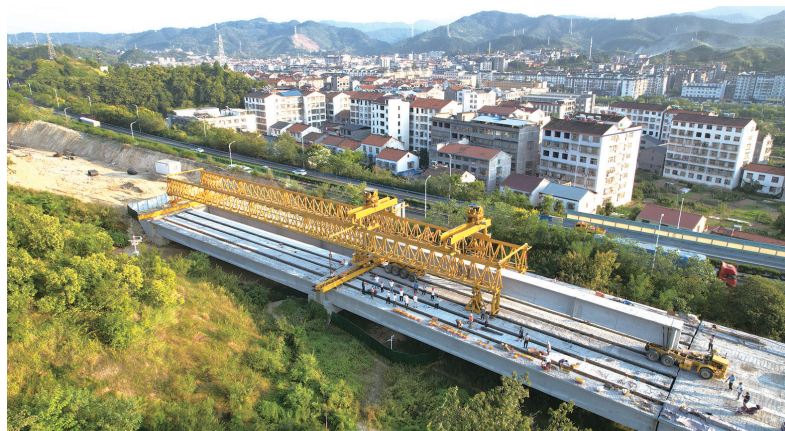
杨家畷大桥主体工程完工。
