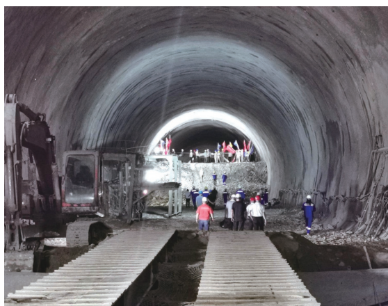
梅家台隧道贯通为西十高铁稳步推进奠定了基础。
