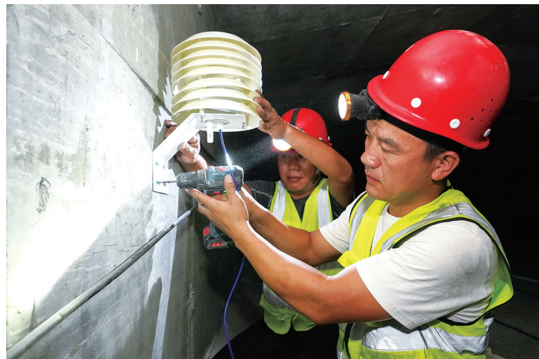
发展大道神定河大桥桥梁箱体内,工作人员正在安装温湿度传感器。
