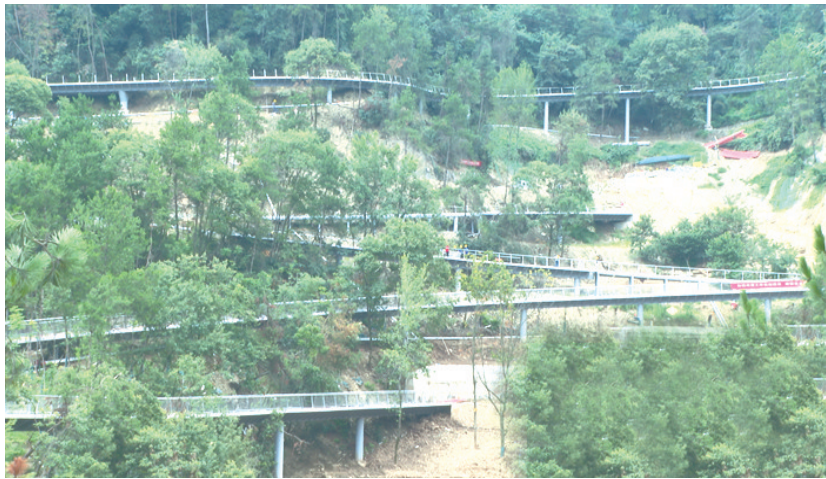
主城区健康步道主体工程已完工。(资料图片)
