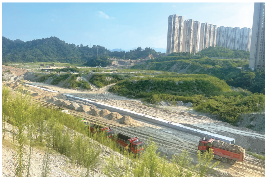
厦门路(一期)施工现场,土石方开挖正在有序进行中。
