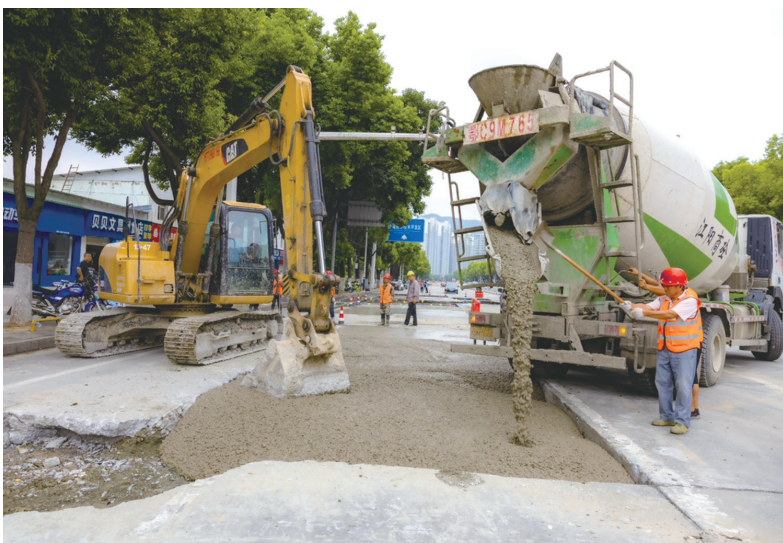
施工人员对破损的水泥路面进行维修。
