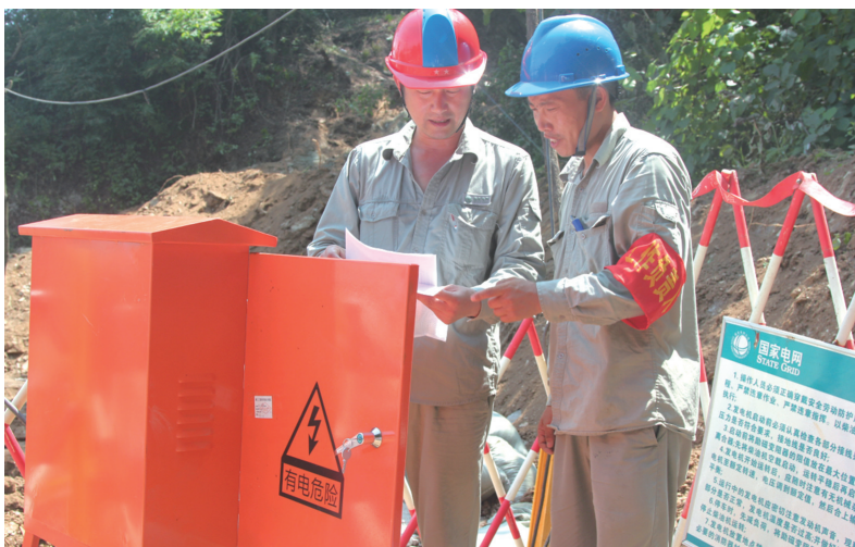
施工现场,工作人员顶着烈日调试设备。
