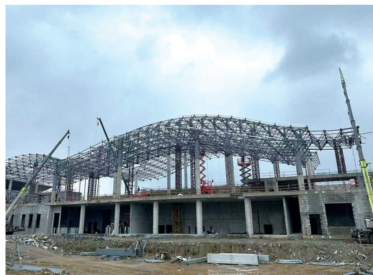
机场新建国际航站楼主体结构基本成形。
