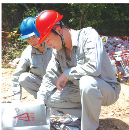
王飞(右)和工友检查工地临时用电安全。
