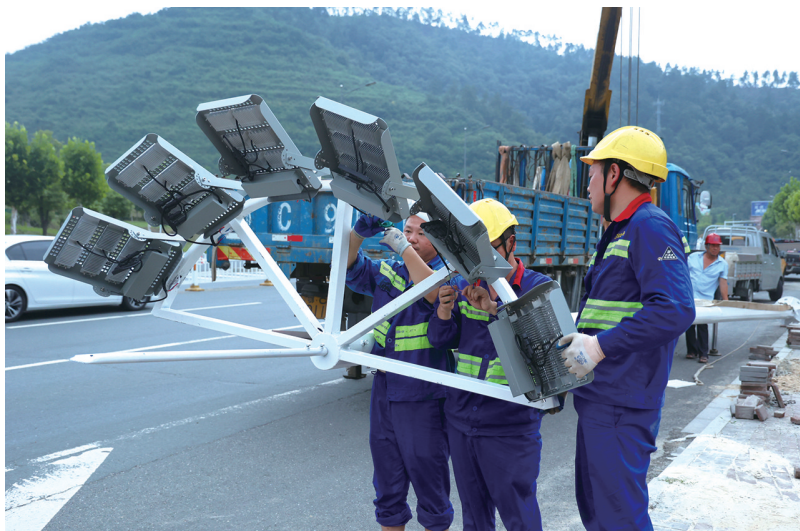
技术人员加紧安装顶部灯具。
