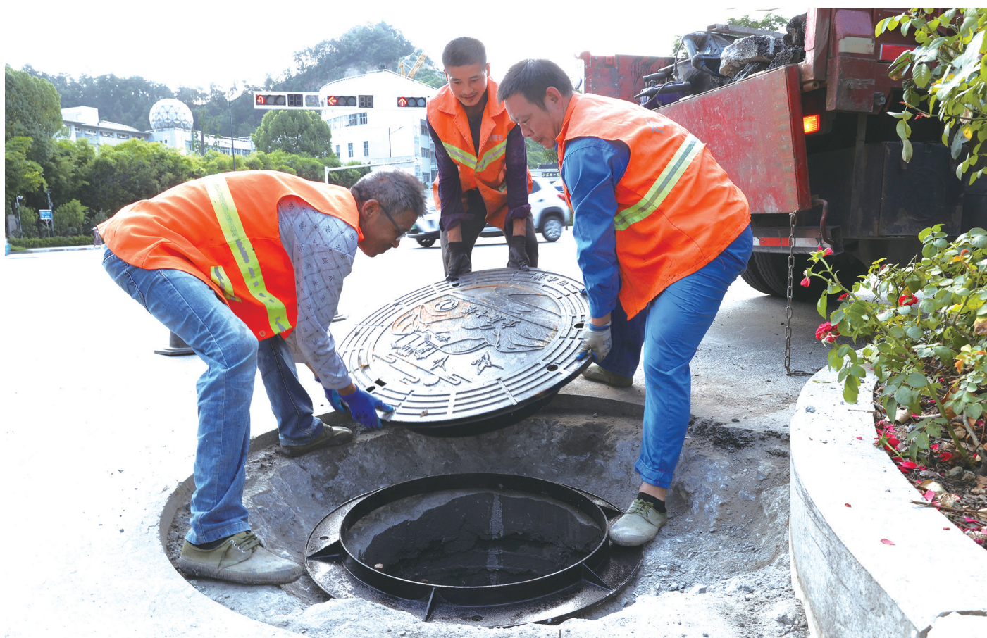
施工人员正在北京路对老旧窨井盖进行更换。
