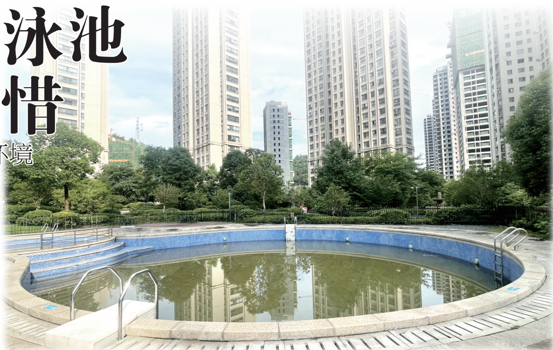
天麟时代经典小区露天泳池没有开放,池子内的水非常浑浊。
