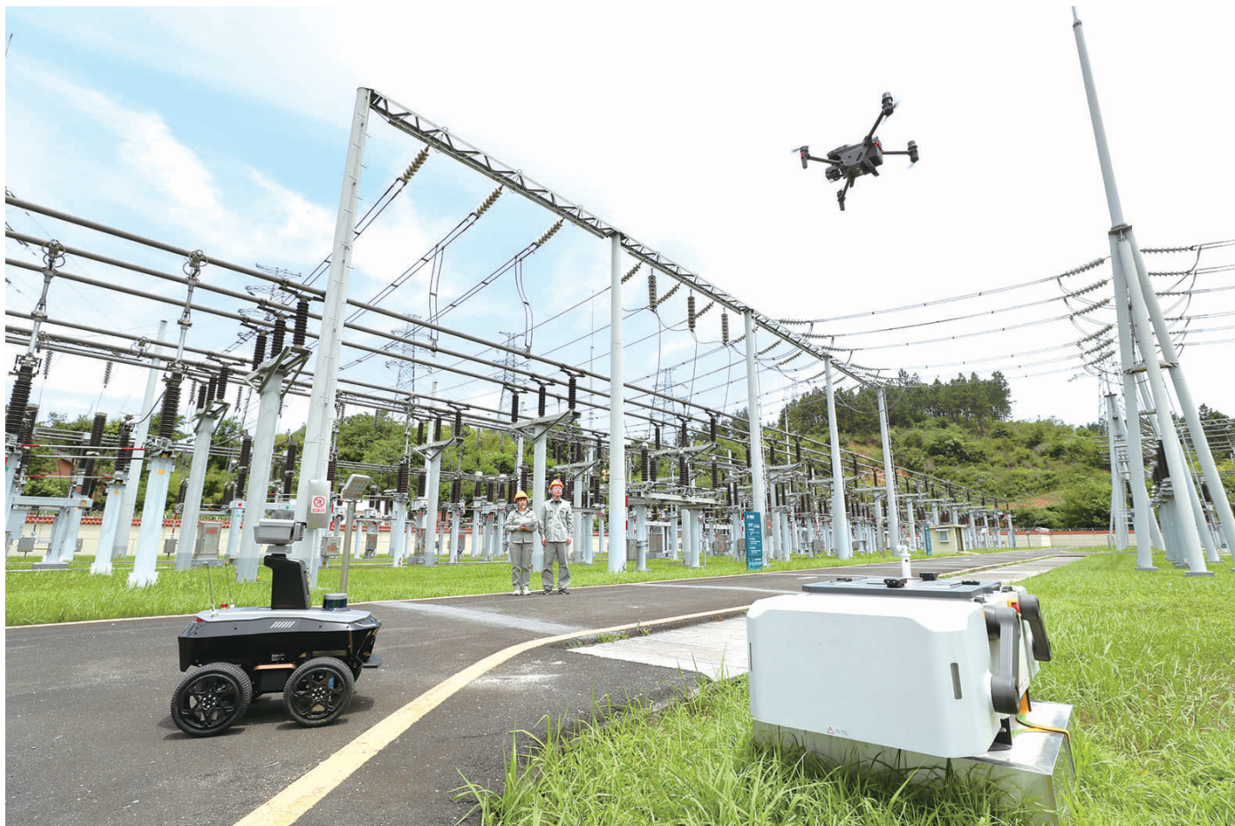
国网十堰供电公司试点开展无人机与机器人地空联合智能巡检,提升巡检质效。
