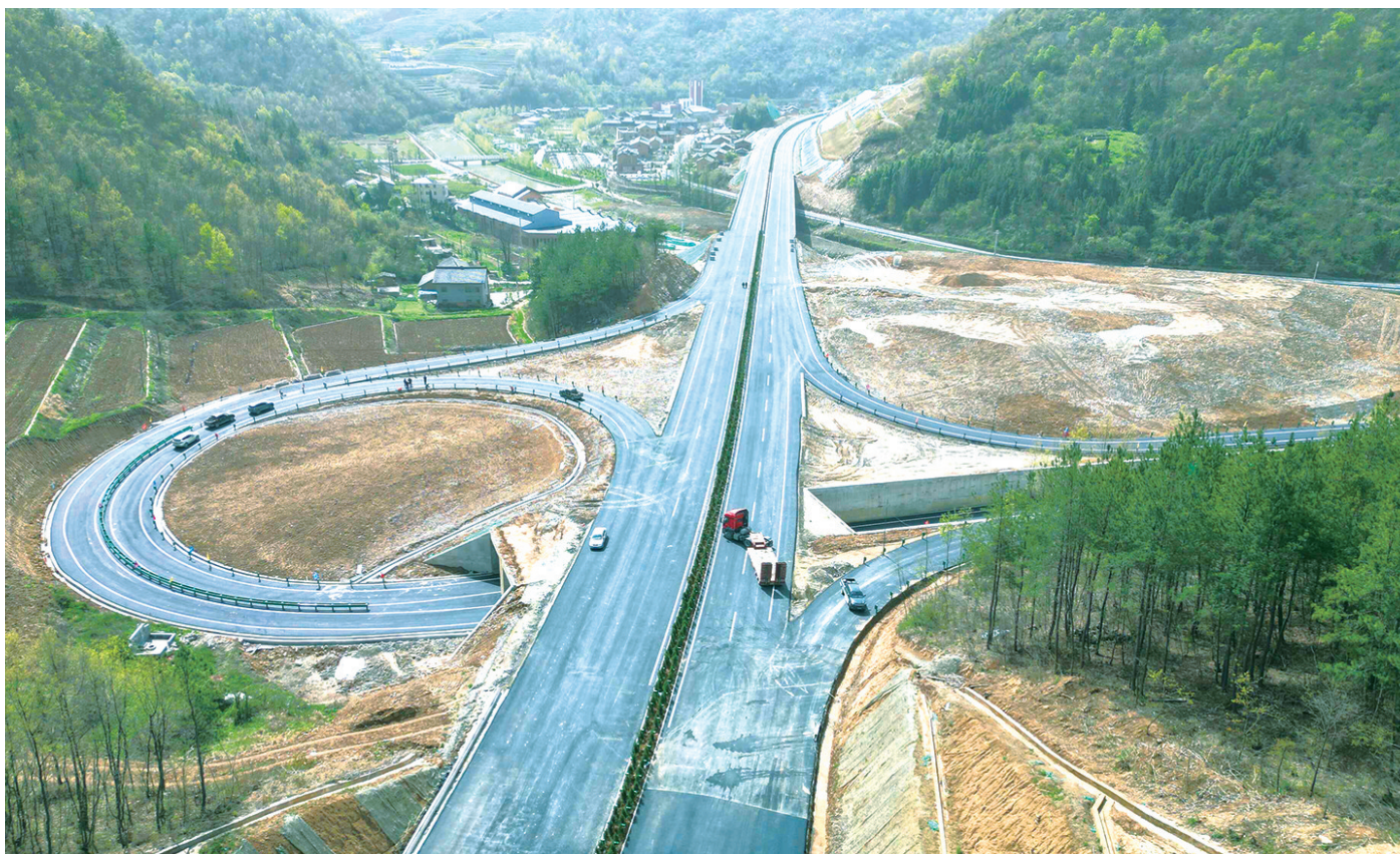
十房一级路房县土城段正在进行扫尾施工。
