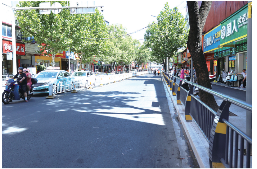
张湾区大岭路示范段改造后路面整治美观。
