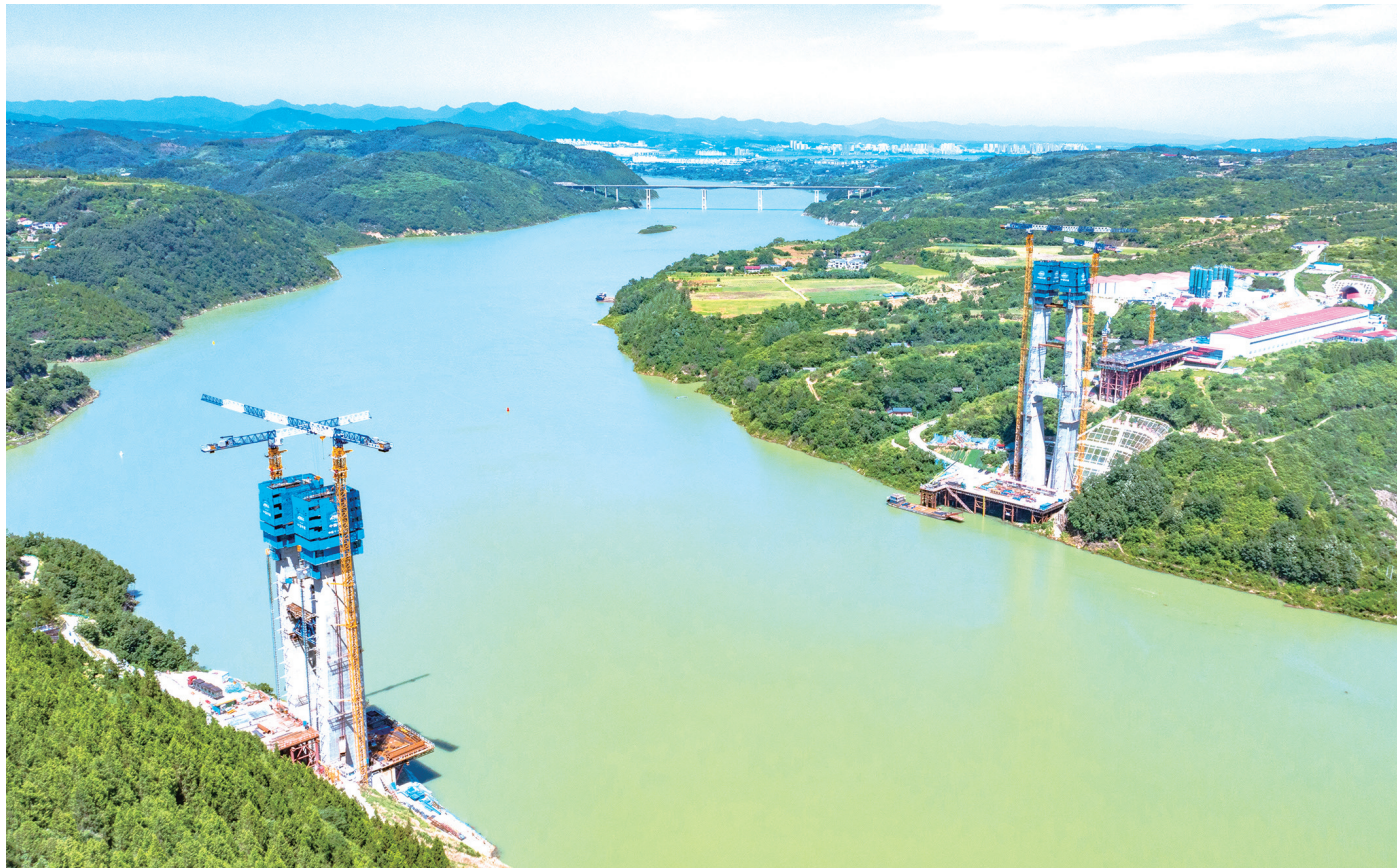
西十高铁汉江特大桥边跨现浇梁第一现浇段浇筑完成,标志着大桥进入主梁施工阶段。
