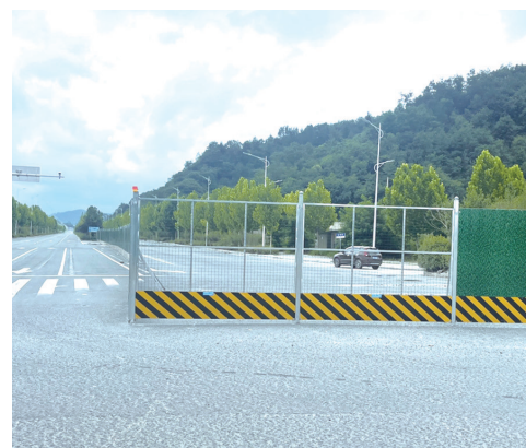
昨日下午,林荫大道佰昌物流园段已开始半幅封闭施工。
