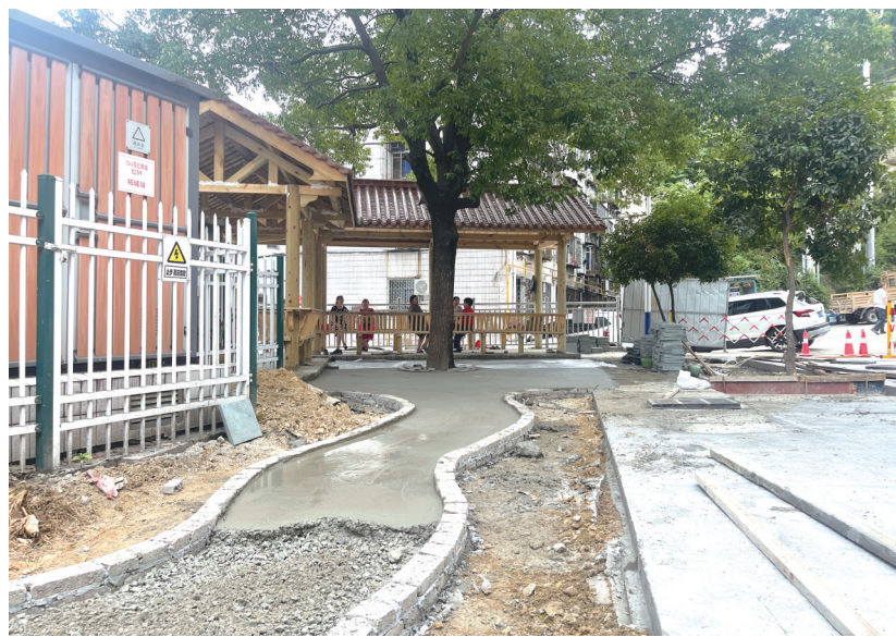
西城佳苑小区改造现场正在进行路面回填。
