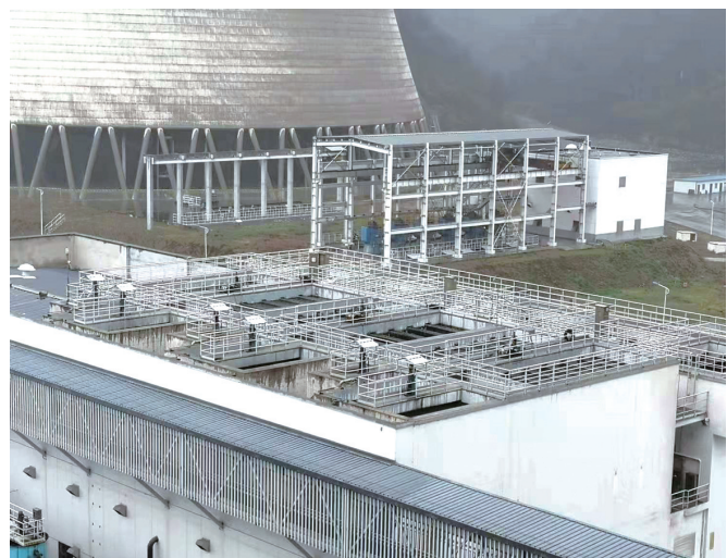
京能中水预处理设备可将污水处理厂送来的中水再次处理。
