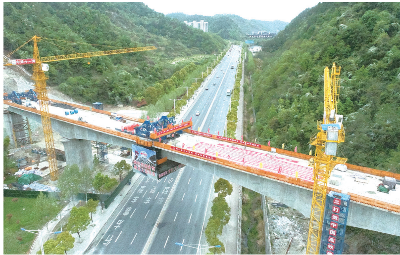
西(安)十(堰)高铁跨汉江大道大桥连续梁顺利合龙。
