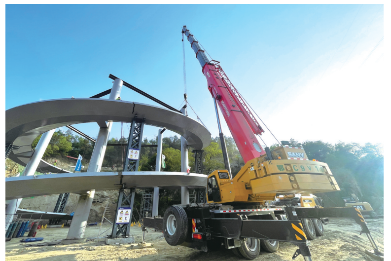
施工人员进行螺旋塔第三层钢箱梁吊装作业。
