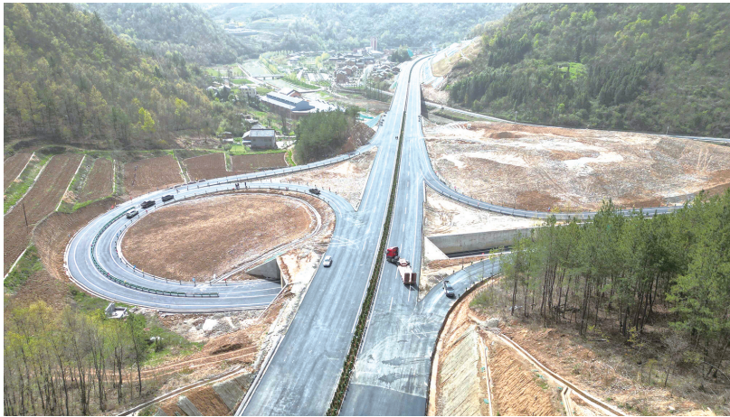
十房一级路一期路基工程全部完工。
