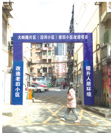
张湾区大岭路片区施工门楼已搭建。
