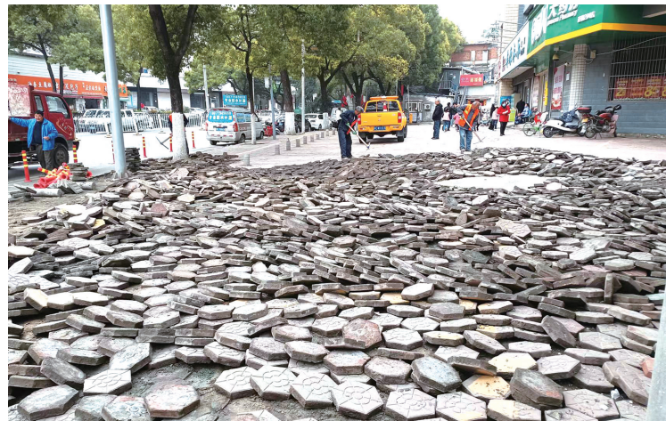
工作人员将人行道上的方块砖挖起,准备重铺路面。
