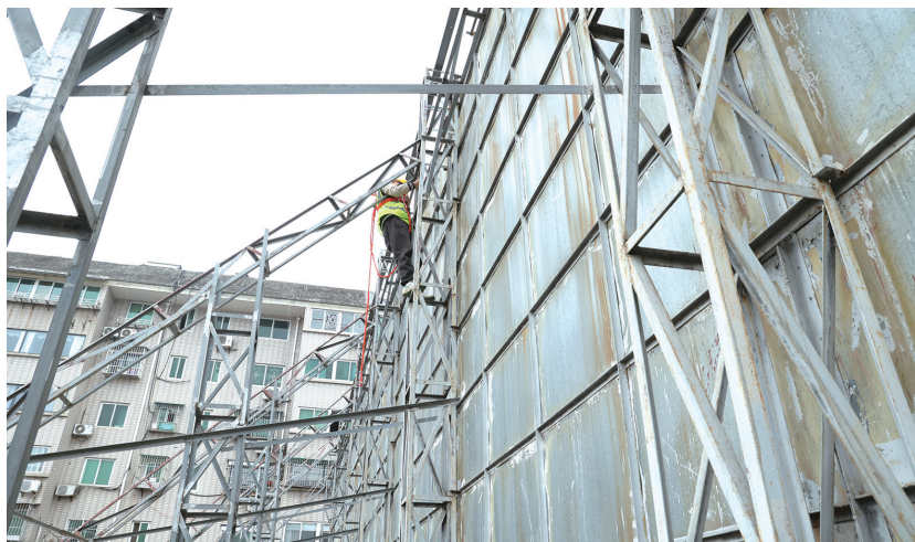
专业检测人员对大型户外广告进行检测。
