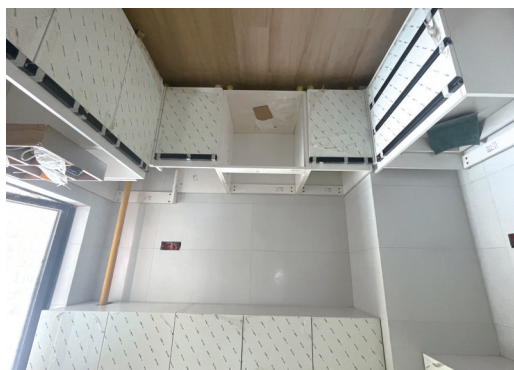
餐台的台面没有安装。
