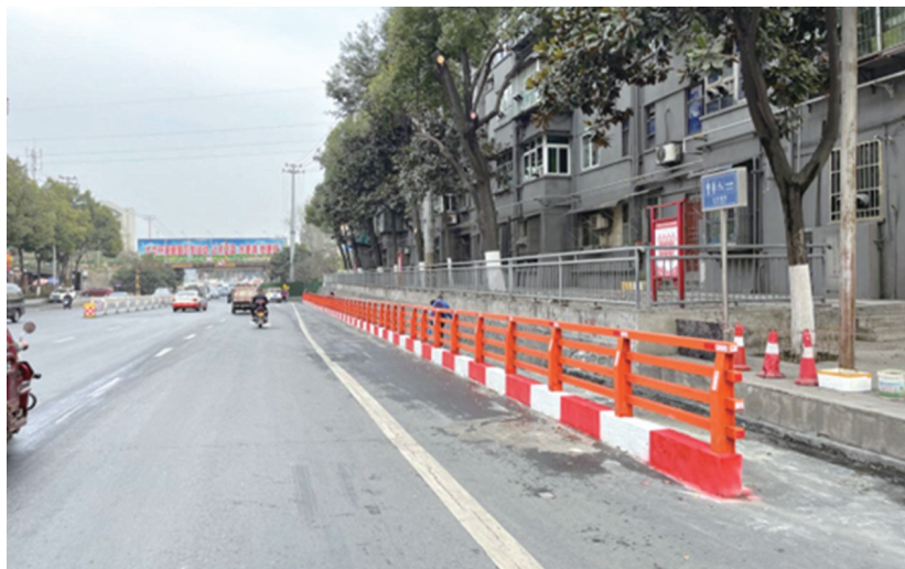
吉安小区外面的马路上隔出了一条专用人行道。
