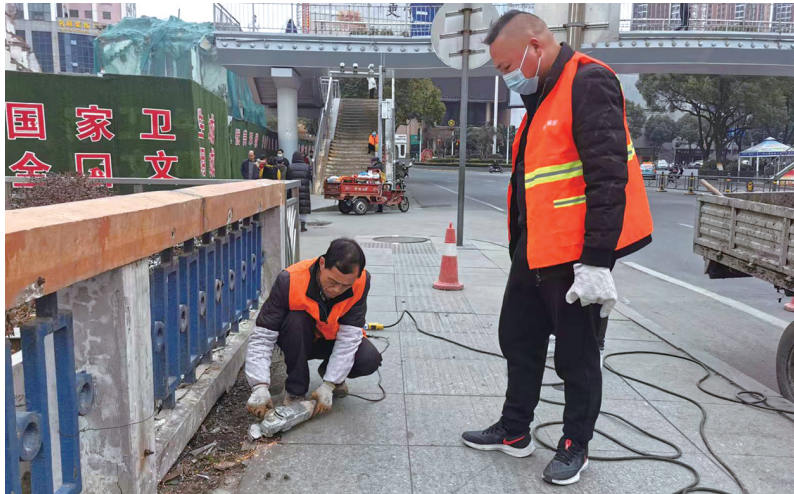
工作人员用锤子、切割机等工具,沿线清理凸起的地钉。
