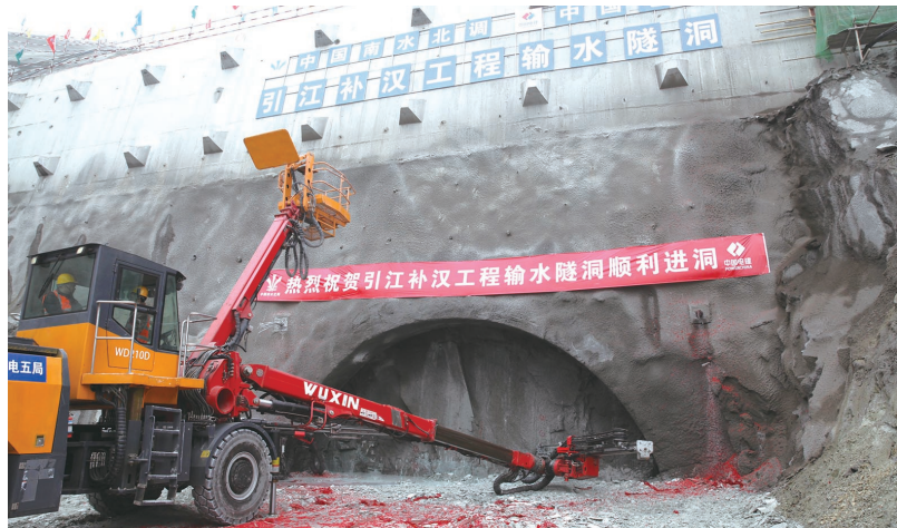
随着多臂凿岩台车启动钻孔施工,引江补汉工程正式进入主体隧洞施工。
