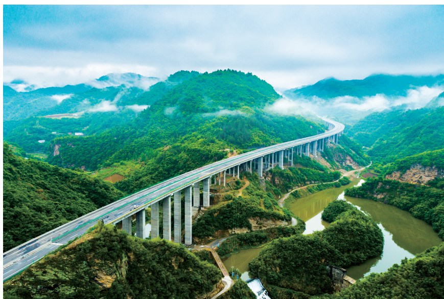
十巫高速公路是十堰目前建设投资规模最大、桥隧比最高的高速公路项目,建成后将填补十堰西南部地区纵向高速公路的空白。
