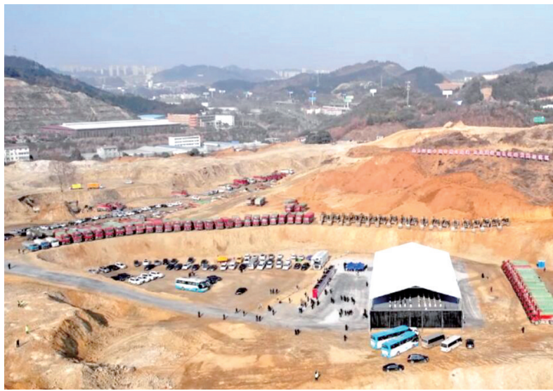
项目建设现场,各种大型机械设备有条不紊地进行施工。
