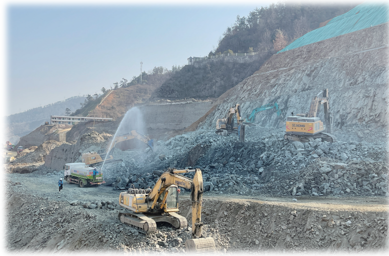
挖掘机开挖、边坡治理等施工同步进行,现场一派繁忙景象。
