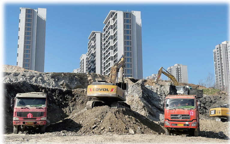
一辆大型挖掘机正在施工作业。
