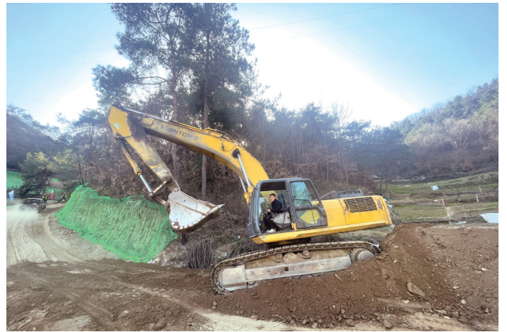
施工人员进行道路平整硬化等作业。
