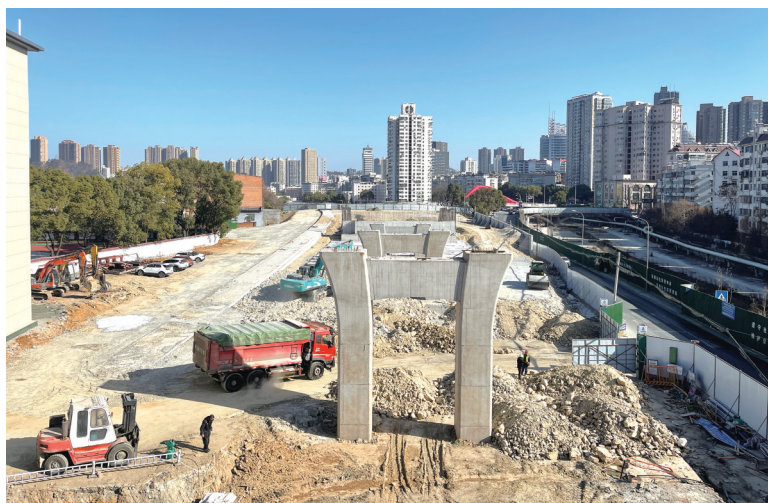
施工现场,工人们各司其职,干劲十足。
