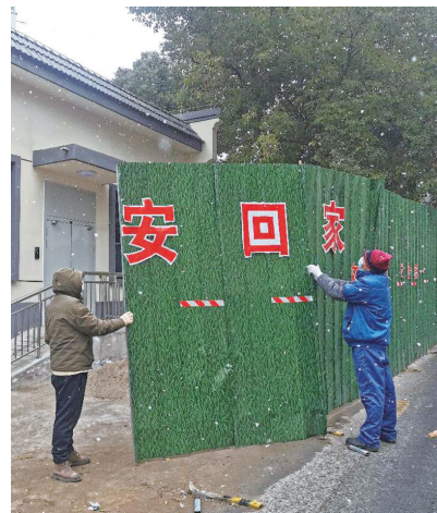
施工人员正在对围挡进行拆除。
