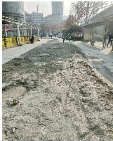
挖开的路面回填后土层裸露。
