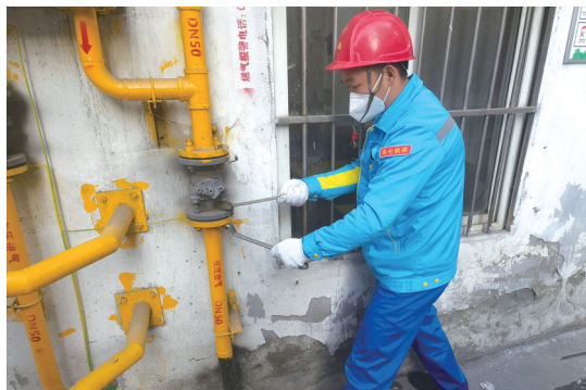
工作人员正在对管网进行检查。
