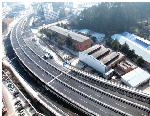
三峡路全长7.58公里,道路等级为城市主干道,是连接花果片区和十堰主城区的交通要道。
