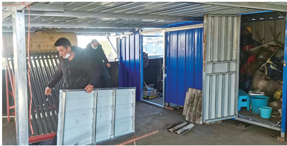
工作人员正在对违建部分进行拆除。
